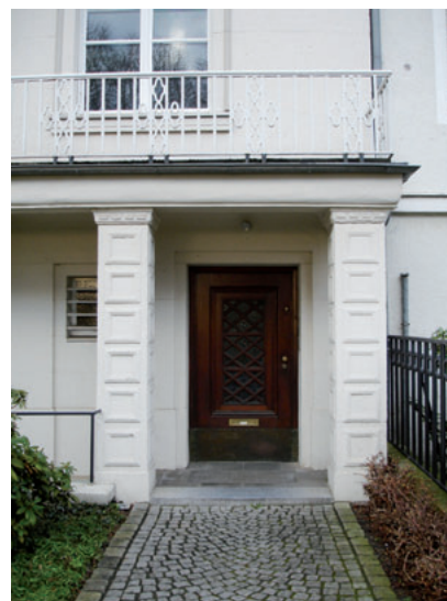
Original-Holztür mit rautenförmigem Dekor und Teilverglasung
