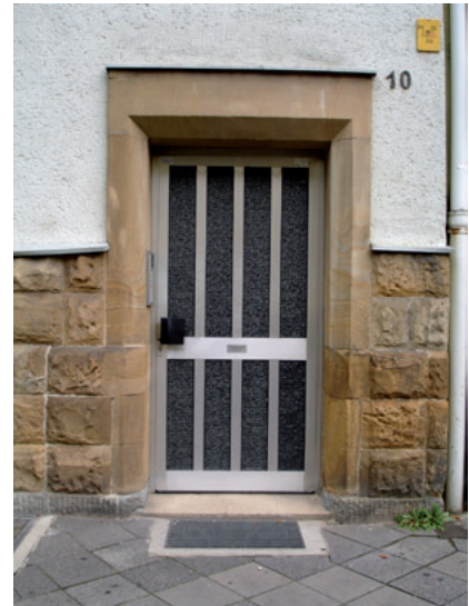
Nachträglich eingebaute Aluminiumtür
