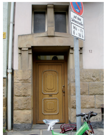
An den Stil des Hauses angepasste, nachträglich gefertigte Haustür aus Holz
